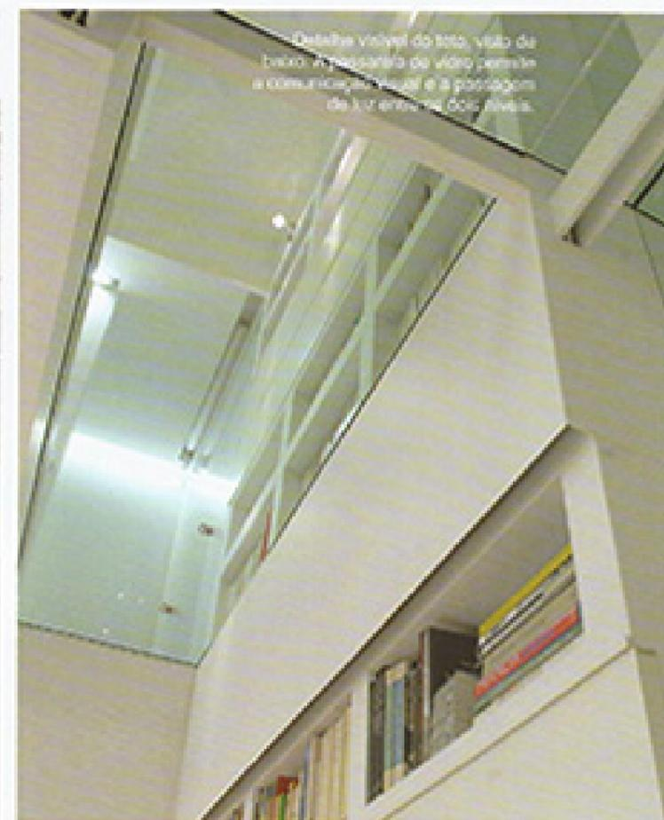
Detalhe visível do teto, visto de baixo. A persiana de vidro permite a comunicação visual e a passagem de luz entre os dois níveis.
